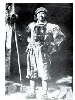
三面村探検の際、民家に残された古式の狩衣付けた著者。「日本の犬と狼」より
