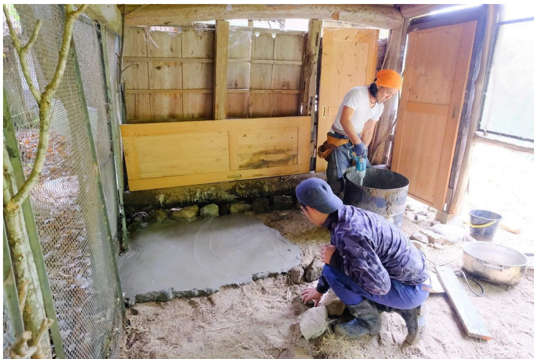
↑犬舎の土間(コンクリート)造り、仲間たちがボランティアで参加する。
